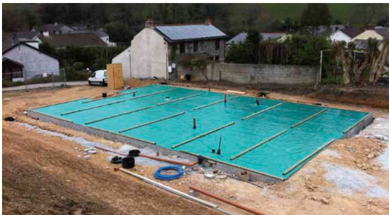
Pose d'une membrane anti-radon en construction neuve © http://www.properteco.co.uk
